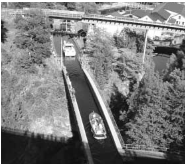
Akvedukten i Håverud er en vandfyldt bro, hvor man sejler over elven.
